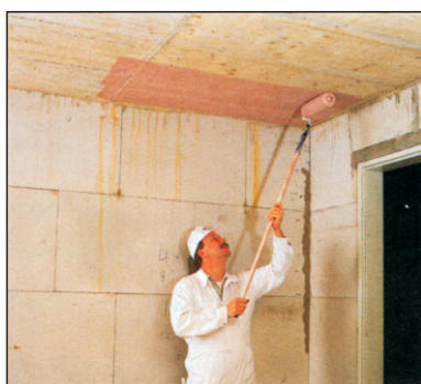
Grundiranje betonske podloge Rikombi-Kontaktom.
