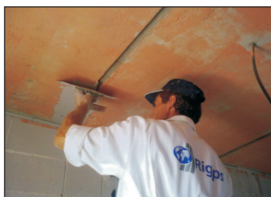
Ispunjavanje betonskih spojeva.
