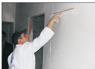
Gletovanje širokom gletericom do perfektne glatkoće.
