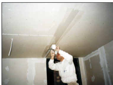
Bandaž traka utiskuje se u ispunjivač.
