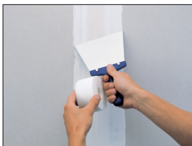
Utiskivanje staklene bandaž trake u nanjeti sloj ispune.
