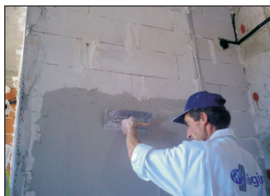
Nanošenje materijala u jednom sloju.
