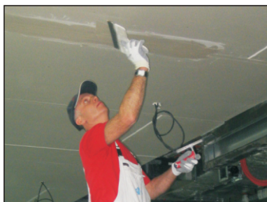
Nanošenje drugog sloja ispune preko bandaž trake.
