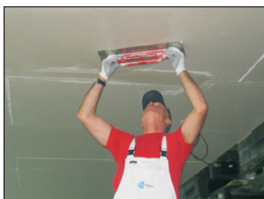
Gletovanje cijele površine ploča Variom u kvalitetu Q3.
