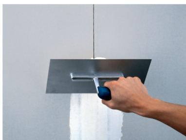
Ispuna spojeva gipskartonskih ploča.
