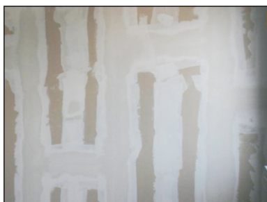
Široko nanošenje ispune na spojeve ploča za kvalitet Q2.
