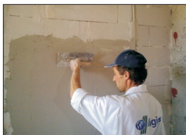
Malterisanje i gletovanje istovremeno.
