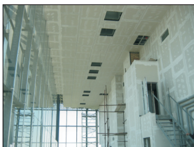
Površina gipskartonskih ploča obrađena u kvalitetu Q1.
