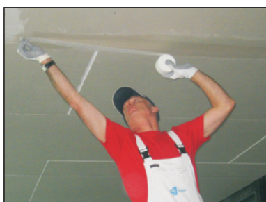
Postavljanje bandaž trake na prvi sloj nanijete ispune Vario.
