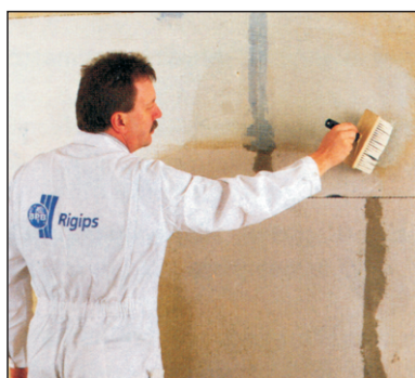
Grundiranje podloge od gas-betona Rikombi-Grundom.
