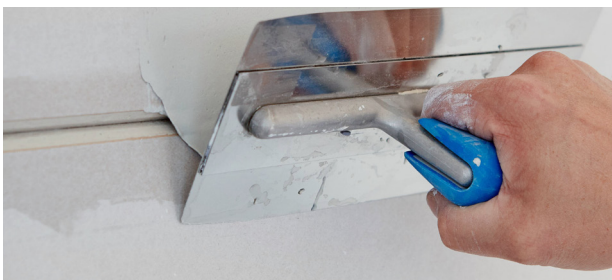
Ispuniti fug-masom poprečnu fugu i odstaniti višak.
