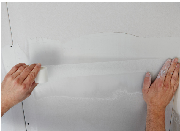
Postaviti Rigips traku za ojačanje spojeva.
