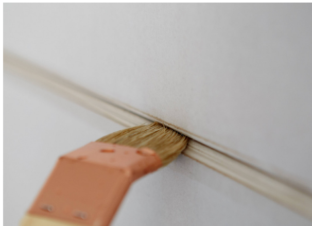
Prethodno nakvasiti poprečnu fugu da masa ne bi prebrzo vezala.
