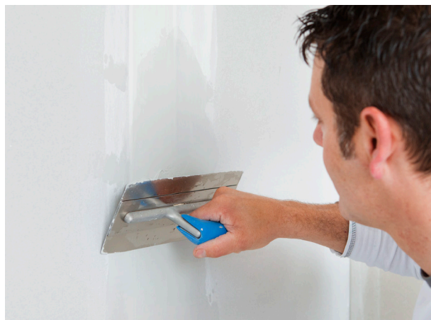
Novo zaglađivanje fuga uraditi tek kad je prvi sloj skroz suh.
