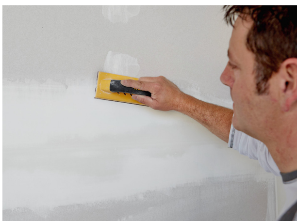
Nakon potpunog sušenja površina se može izbrusiti.
