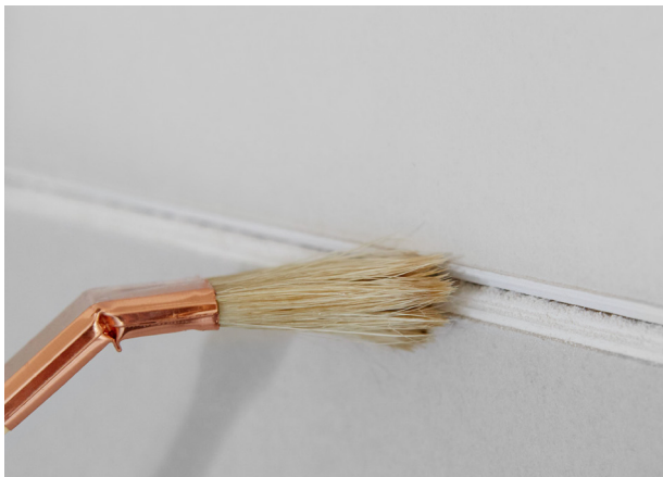
Odstraniti gipsanu prašinu zbog boljeg prijanjanja.
