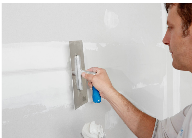
Postavljanje mase za fugiranje 1mm debljine.
